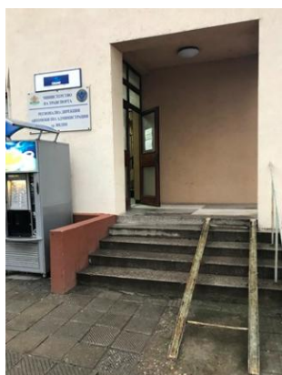
Автомобилна администрация - Видин (рампа, която не отговаря на техническите стандарти и не може да се използва от хора с увреждания)
